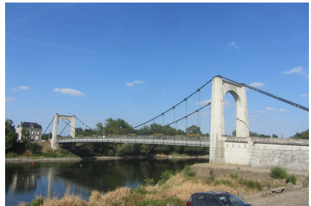
Chaque jour, jusqu'à 10 000 véhicules circulent sur le pont de Chalonnnes-sur-Loire (Maine-et-Loire).
