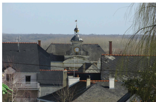
Février 2014. Hôtel de Ville, vue de la place Saint-Brieux
