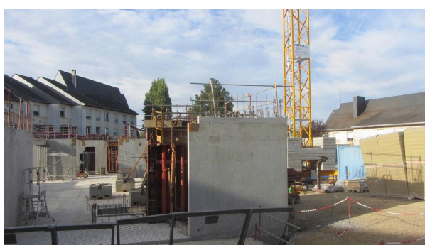
Les travaux pour la reconstruction de l'hôpital de la Corniche angevine ont commencé.
