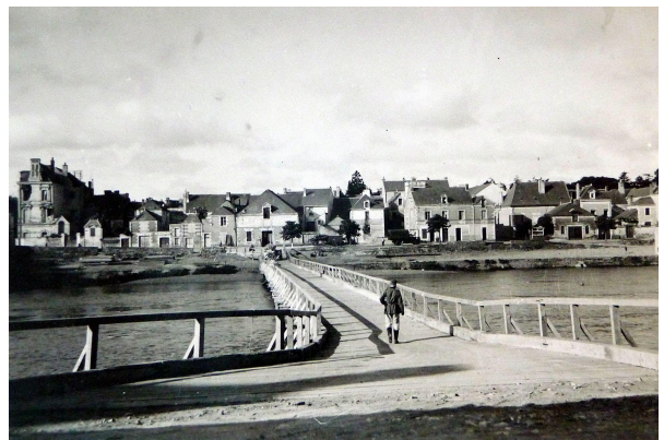
Juillet 1940. Fin de construction de la passerelle quai Gambetta
