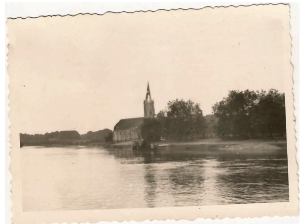
Bombardement de l'église Saint-Maurille.
