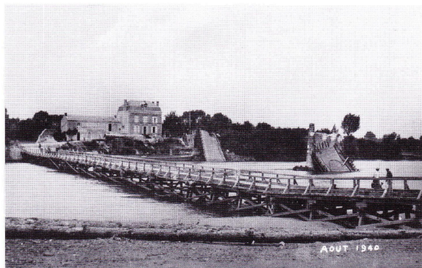
Août 1940. Une passerelle en bois montée sur des pieux fut érigée pour le passage des piétons. Un peu plus loin, en amont, se trouvait un autre pont en bois sur des bateaux pour le passage des véhicules.
