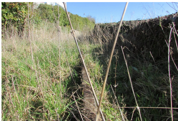
11 février 2018. Ancienne voie ferroviaire
