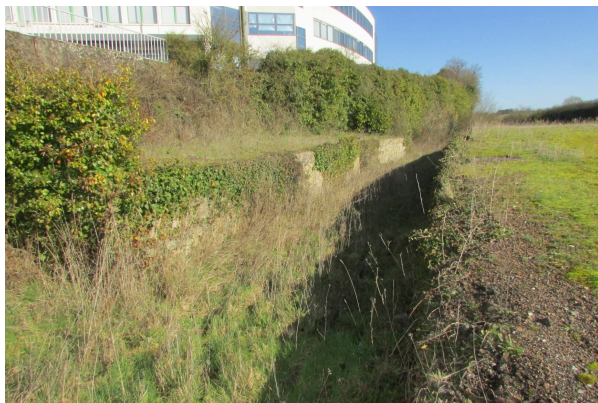
11 février 2018. Ancienne voie ferroviaire
