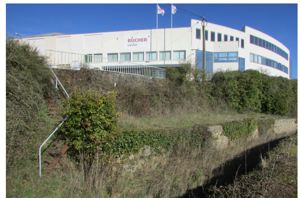
11 février 2018. Ancienne voie ferroviaire
