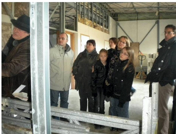
Pendant la visite du local en chantier, samedi dernier.
