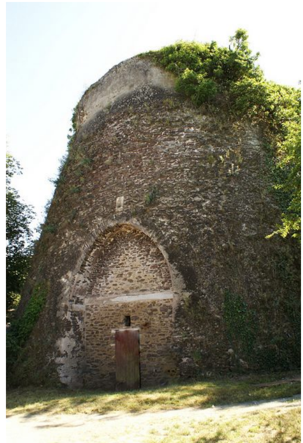
Juin 2010. Four à Chaux de St Vincent construit en 1700
