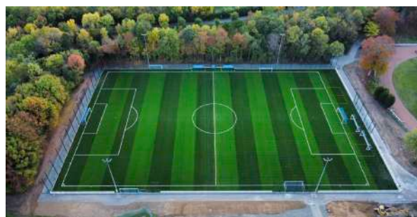
Nouveau terrain de football synthétique à Chalonnnes sur Loire. 20 octobre 2022
