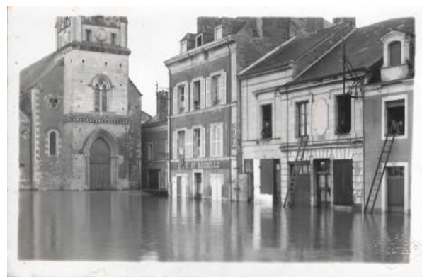
Janvier 1936. Place Saint-Maurille
