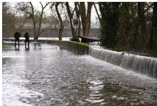
Les Ponts-de-Cé, février 2021. L'eau du fleuve déborde sur la route de Juigné, au niveau du lieu-dit Les-Grandes plaines.
