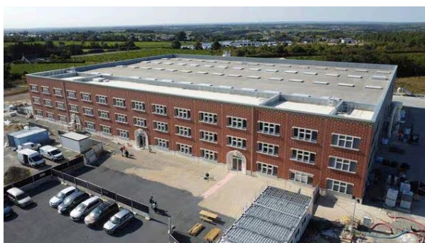
Le nouveau siège de l'entreprise Néolithe, avec façade en briques locales, dont la construction vient de se terminer dans l'Actiparc du Layon, à Beaulieu..
