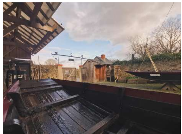
10 février 2024. La Civelles & l'Alose sur le chantier.
