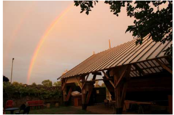
16 octobre 2016. Arc-en-ciel sur le chantier.
